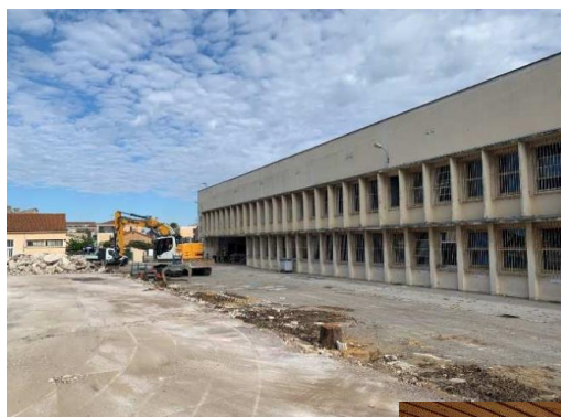
Avant la déconstruction du bâtiment
