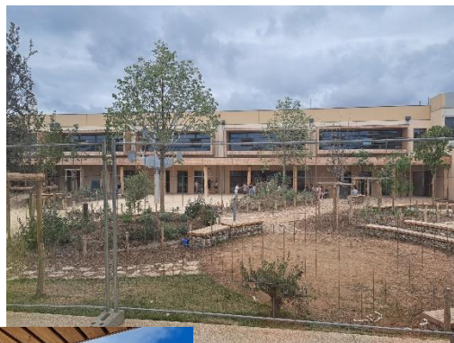
Nouveau bâtiment et cour d'école désimperméabilisée
