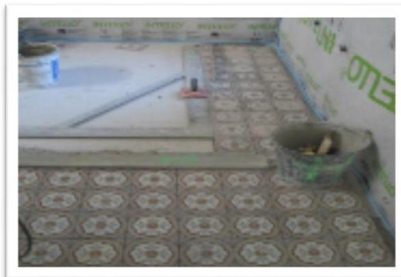
*Figure 33 Dépose et repose de carreaux ciment de carrelage lors de la réhabilitation d'un bâtiment*
